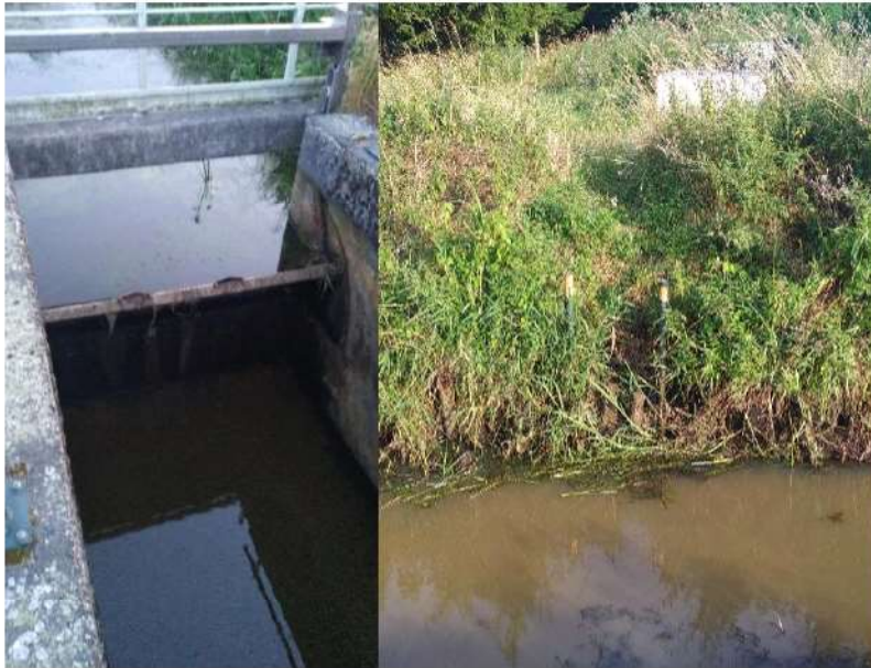
Figuur 7: Links: Stuw afleidingskanaal nabij de Loonsedijk (ter hoogte van de Endepoel) gemaakt op 22-06-2023 door [REDACTED] [6]. Het is duidelijk dat het afvoer minimaal is. Rechts: Foto van de inlaat van de pomp in het afleidingskanaal van [REDACTED] van 12-07-2023; de pomp staat uit, zoals ook terug te zien aan het vlakke wateroppervlak.
